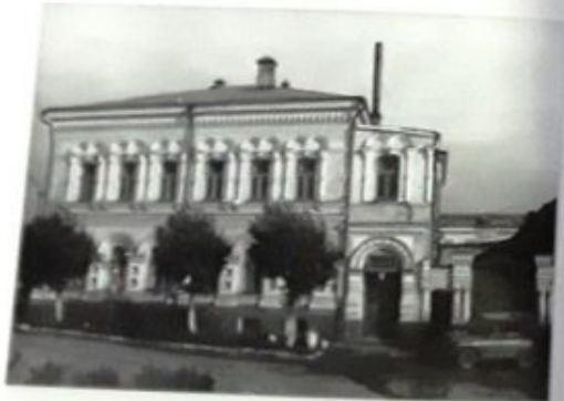
Особняк Ковалёвых – Сибирский банк. Фото 1979 г.
